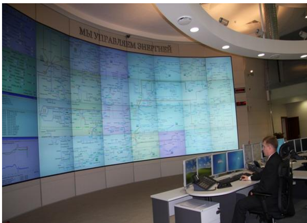
Рис.3. Большая видеостена (4x8 кубов) со структурной схемой.
